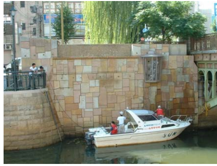
102 ムラテ岸壁クリニック
